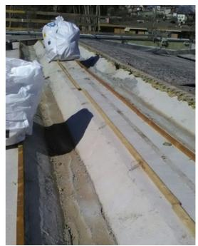
Operazioni di carico rifiuti contenenti amianto e movimentazione in quota nuove coperture
