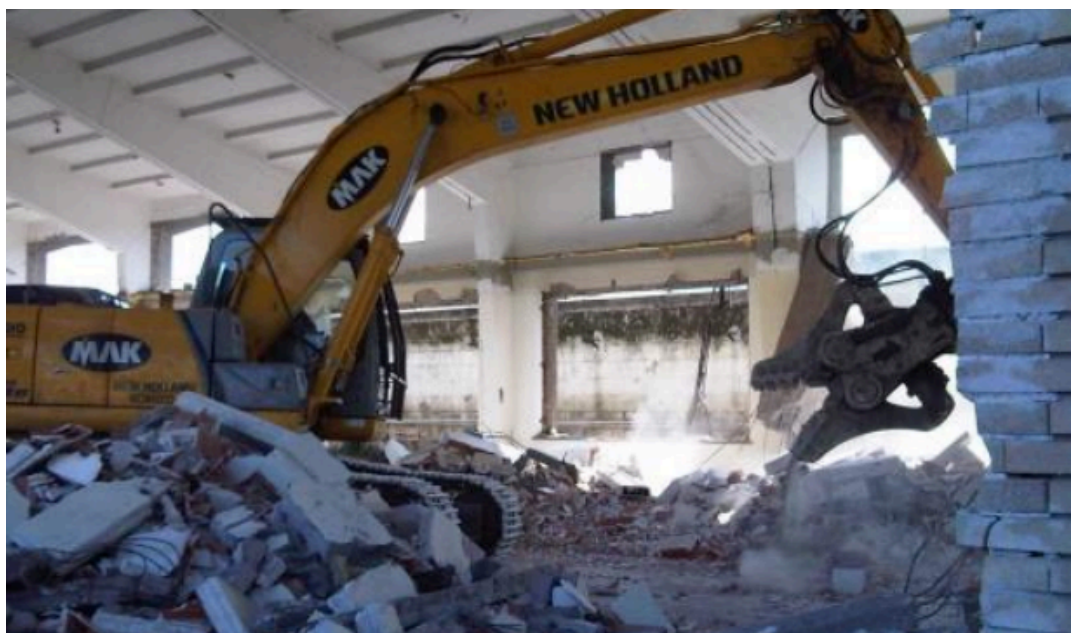
Demolizione con pinza frantumatrice
