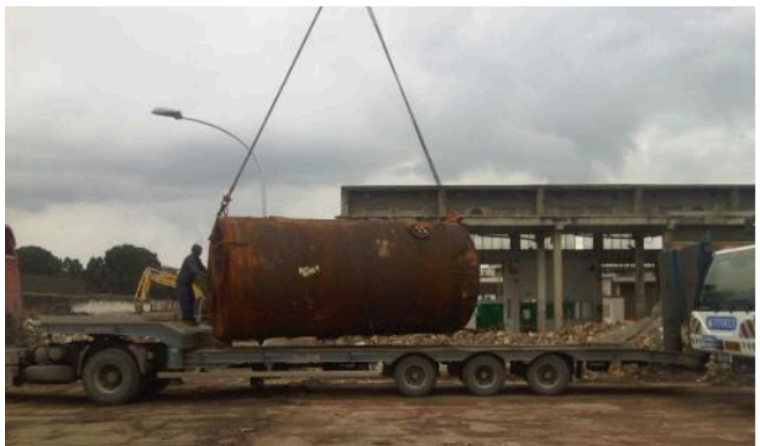
Carico della caldaia da 14 ton
