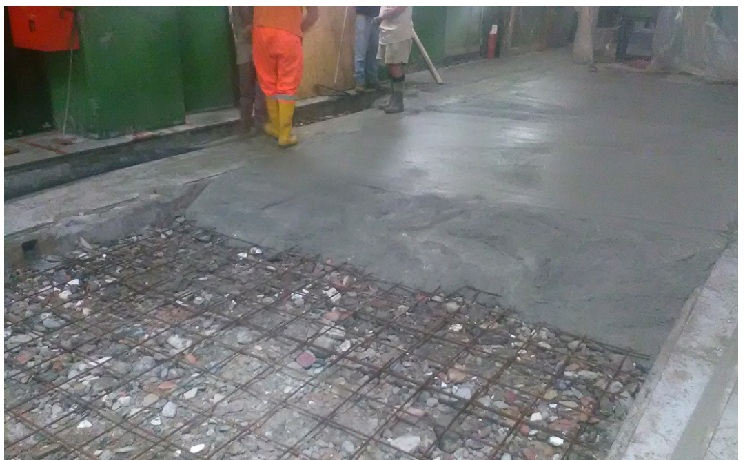
Ripristino dell'area dopo la demolizione
