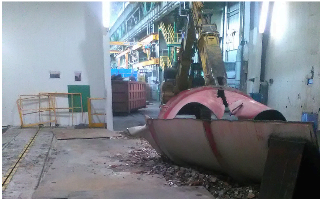
Fasi finali demolizione autoclave
